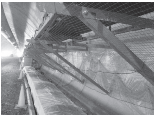
写真—13 連続ベルトコンベヤ養生ネット
