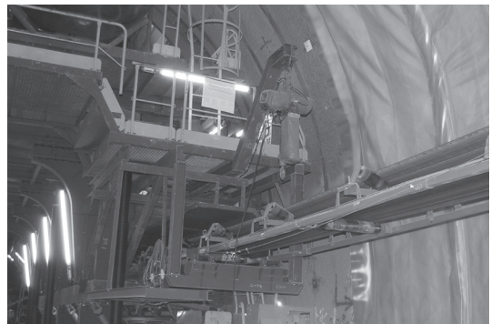
写真—15 覆工部防護
