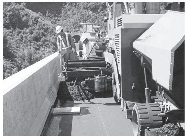
写真-2 ラインリーダによる施工状況
