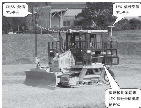
写真—1 実証試験用ブルドーザ
