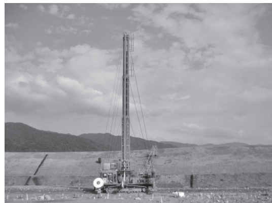
写真-1 PBDの施工状況
