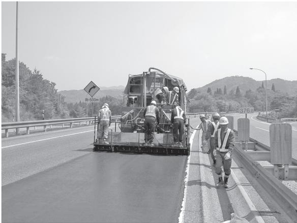
写真-2 マイクロサーフェシング工法
