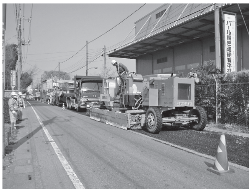
写真一 1 加熱かきほぐしによる路面維持工法の機械編成
