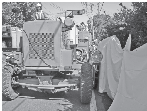
写真-7 施工状況（埼玉県蓮田市）
