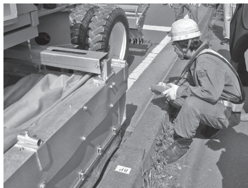
写真-4 機械操作状況
