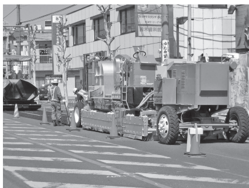
写真-6 施工状況（埼玉県久喜市）
