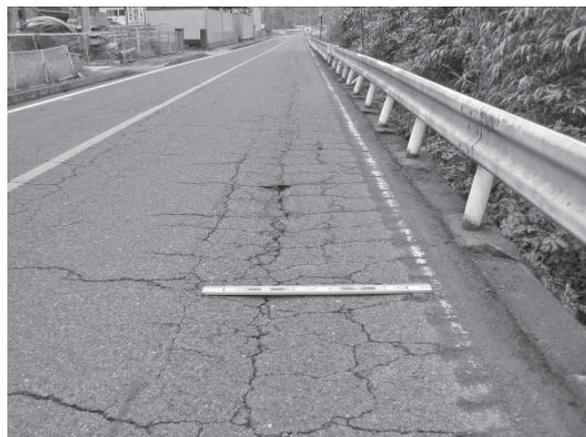
写真—5 施工前の路面状態
