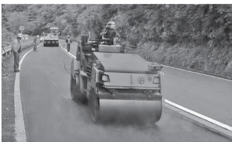
写真—10 タンデムローラによる初転圧
