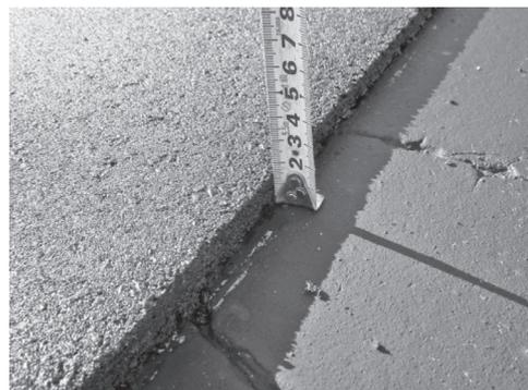
写真-3 平均施工厚さ15mm
