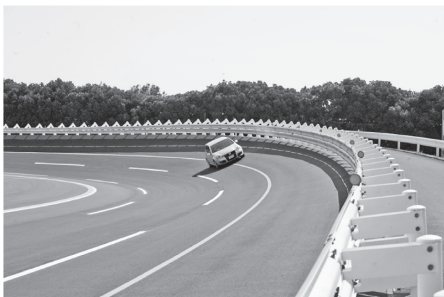
写真一 5 完成した旋回傾斜路（大バンク）を試走
