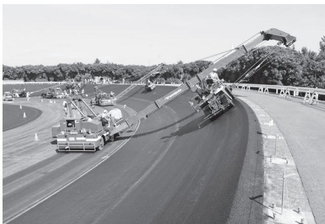
写真一 4 転圧状況
