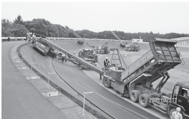
写真一 3 敷き均し状況
