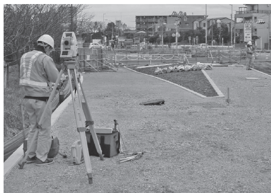
図-9 道路工事完成平面図のための測量実施状況
