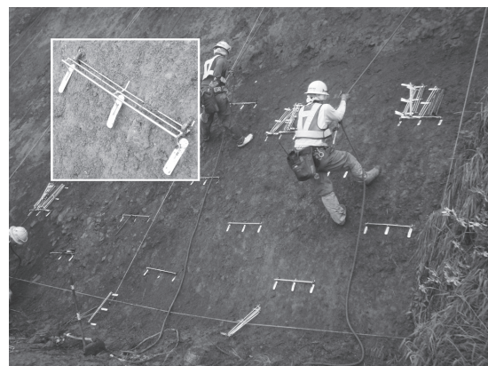
写真-3 基盤キャッチャーの設置状況
