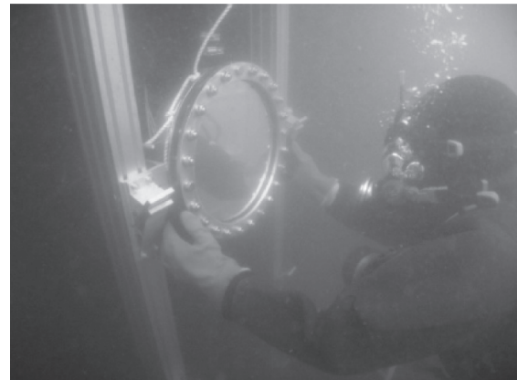
写真2 鋼矢板岸壁での計測状況(水中)
