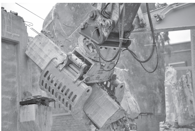
写真一 3 MG1500 による仕分け作業
