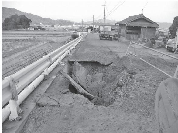
写真—3 パイプラインからの漏水による道路陥没
