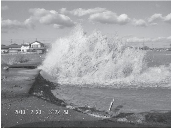
写真—2 パイプラインの破裂による農地浸水
