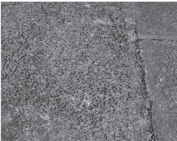
写真－1 摩耗して骨材が浮き出ている水路壁
