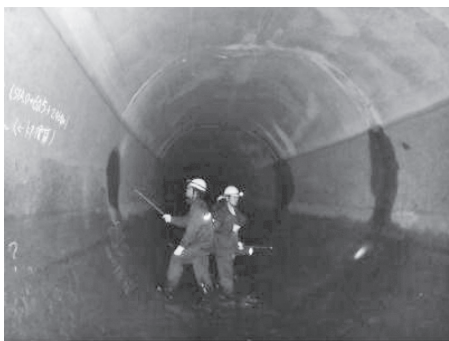
阿讃トンネル内部
