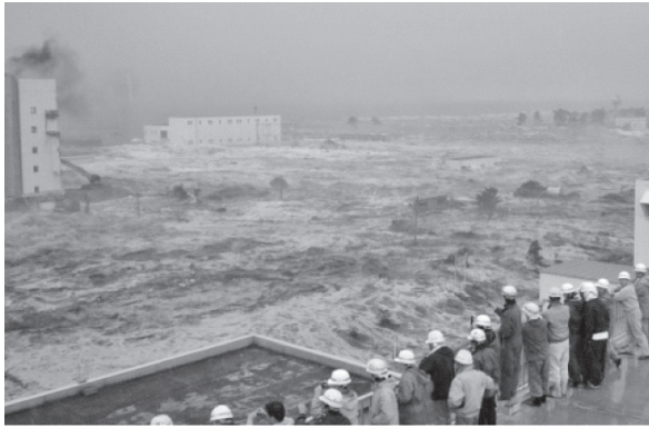
(出典) 国土交通省下水道部資料 写真一 地震直後の下水道施設の被災状況
