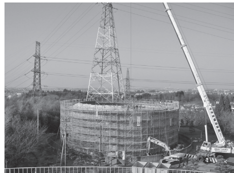
写真—11 重機の配置
