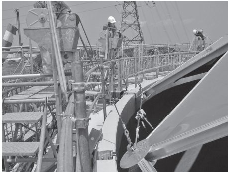
写真-12 ウィンチ上架の状況
