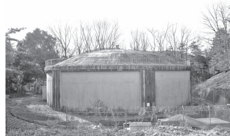
写真-15 改修前の配水池
