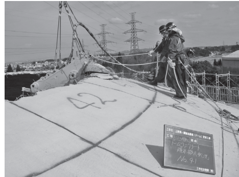
写真—10 解体の状況
