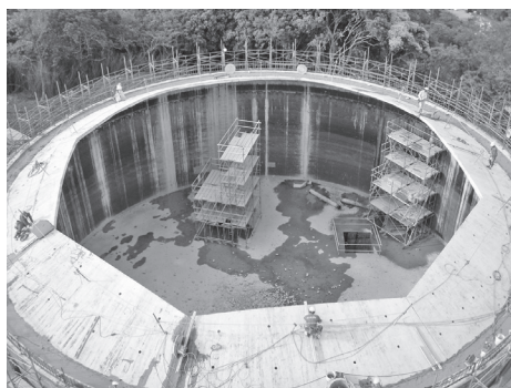
写真-4 RC ドーム屋根解体状況
