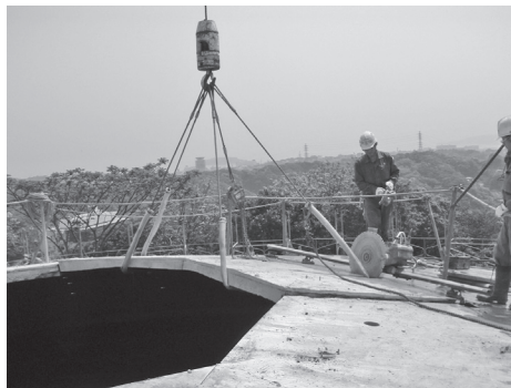
写真-3 ウォールソーによる切断の状況
