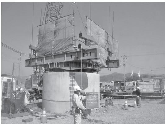
写真-1 PCウェルの施工状況写真
