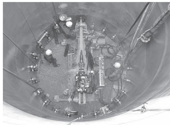
写真-2 圧入振動式施工の施工状況写真
