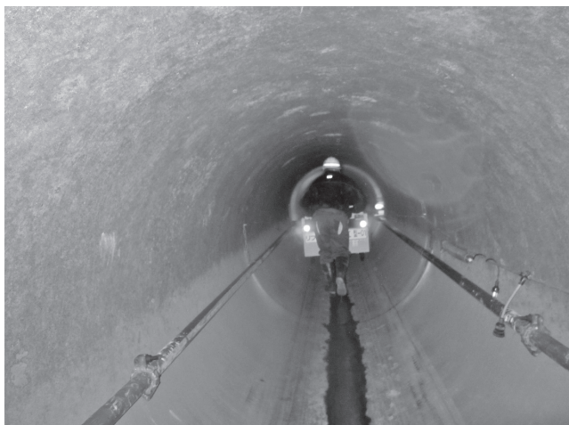
写真一三 既設管内注入用鋼管取付け
