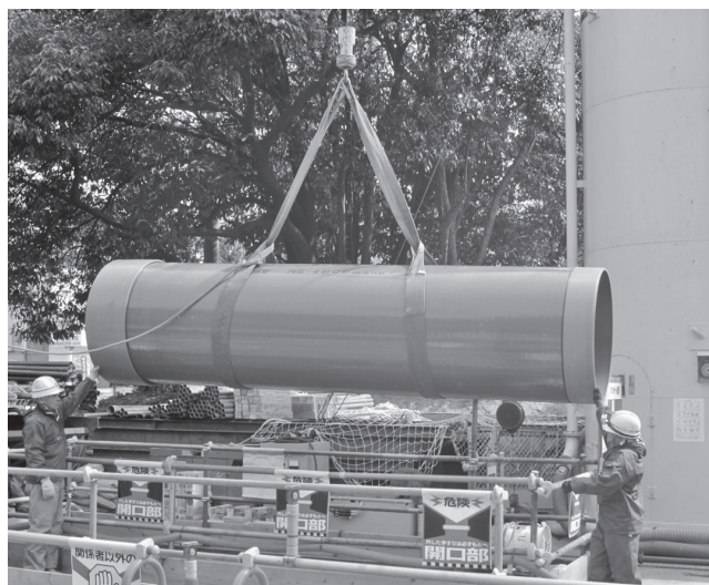
写真一四 管の吊りおろし
