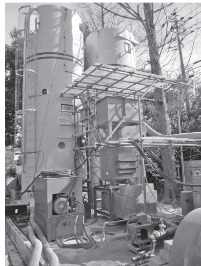
写真-2 据付プラント設置
