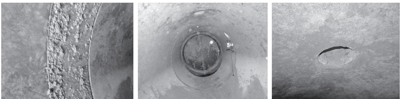
写真-1 既設管内状況
