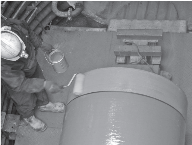
写真一七 滑剤塗布状況
