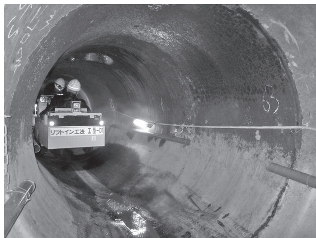
写真一六 既設管内の運搬状況
