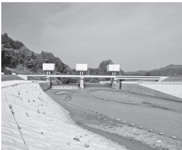
写真一五 完成後（通水中）
