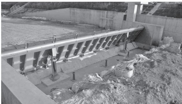
写真一 2 起伏ゲートの施工例
