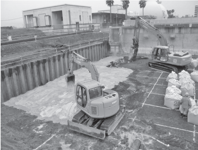
写真一六 セメント散布状況
