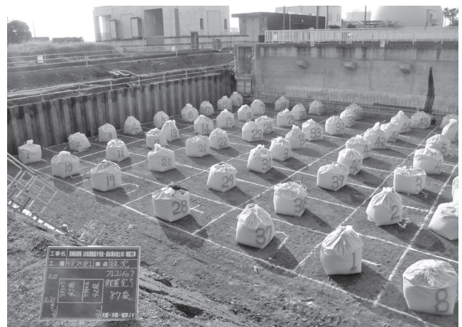
写真－5 セメント検収状況
