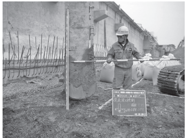
写真一八 攪拌深さの確認状況
