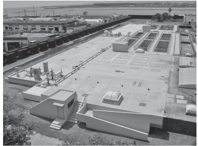
写真—10 宮崎処理場9号処理施設・雨水滞水池全景
