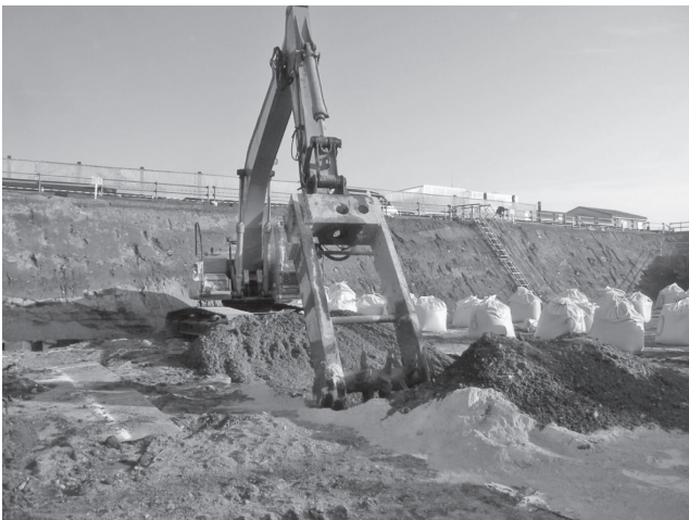
写真一七 セメント攪拌状況
