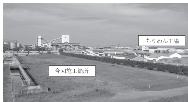
写真-1 現場着工前全景
