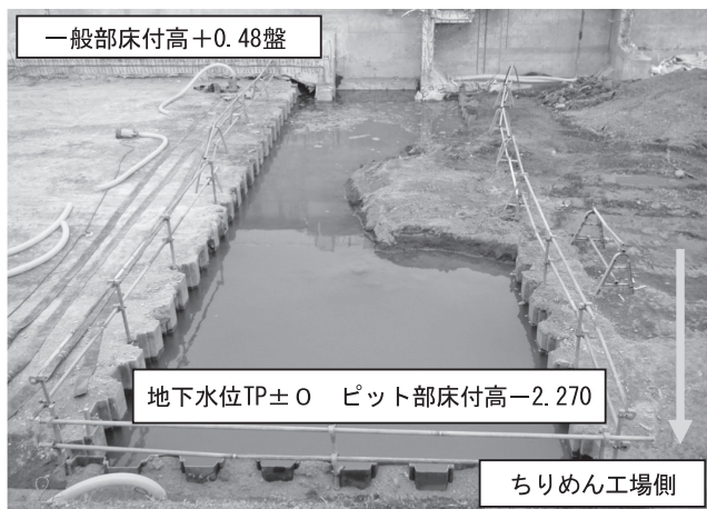
写真一2 水処理施設ピット部水位状況
