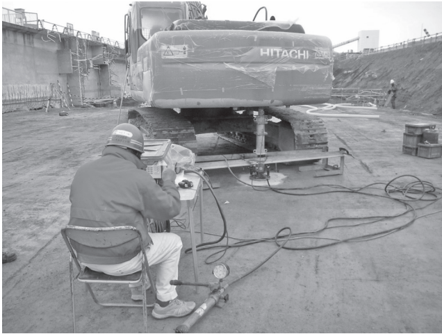
写真—9 平板載荷試験状況
