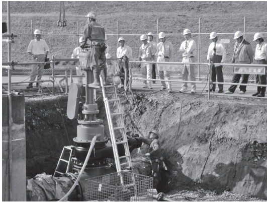
写真一六 穿孔機にて穿孔中
