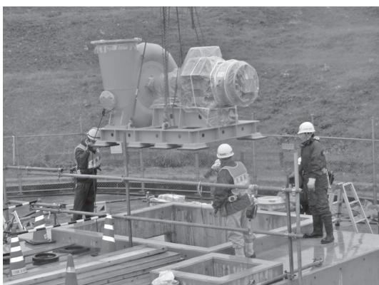
写真一九 水車・発電機搬入
