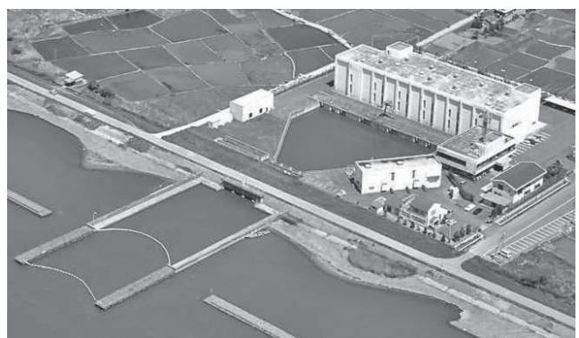
写真一 霞ヶ浦揚水機場
