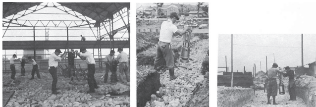
写真1-11 (株)明和製作所 ジャンプランマ施工状況
