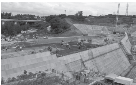
図-1 億首ダム施工状況
