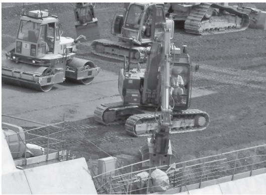
図一 14 端部法面締固め実施状況
