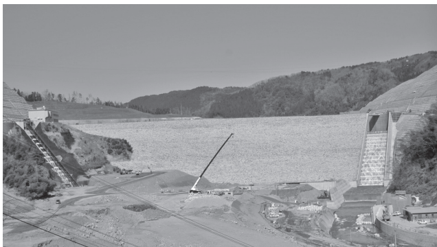
写真一1 目標最高水位到達時の殿ダム堤体および洪水吐き減勢部（カスケード型減勢方式）を流れ出る様子
