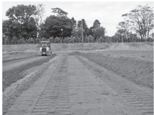
図-6 3D-MC 2 の整地性確認状況
