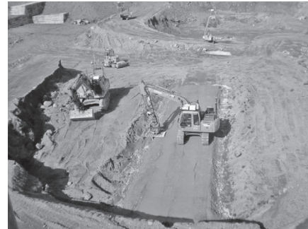
写真一八 RCC コンクリート先行打設工法施工状況
