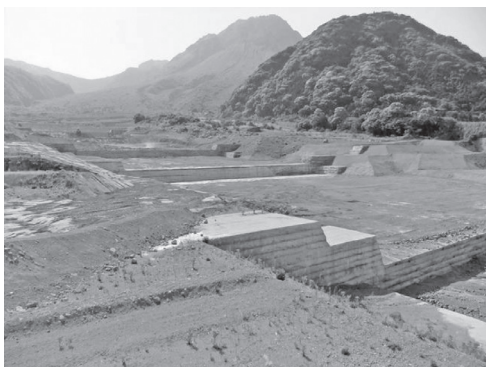
写真一2 RCC工法による床固工
