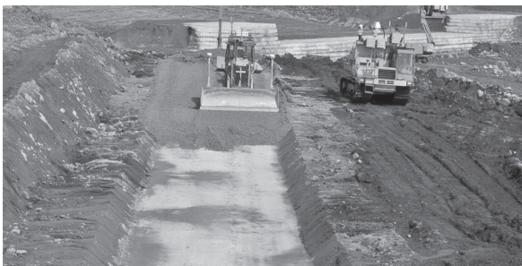
写真—3 敷均し状況
