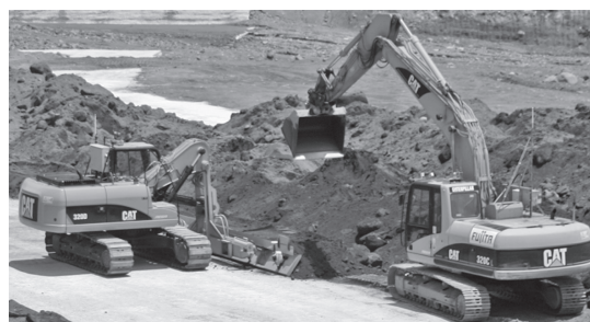
写真—5 フォーミング・ブレード工法 施工状況
