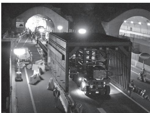
写真-3 多軸台車運搬・据付け状況
