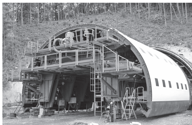
写真—1 セントル全体写真
