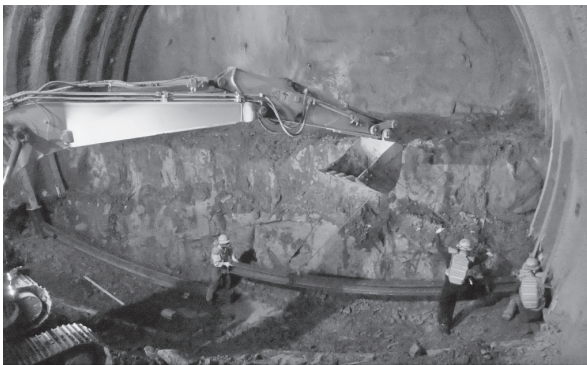
写真一2 鋼製ストラット設置状況
