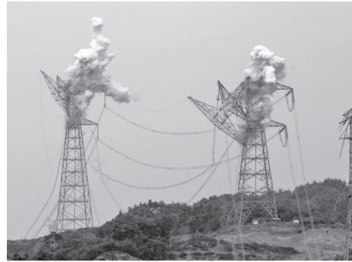
写真—4 災害を受けた送電線鉄塔の復旧工事
