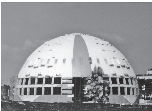
写真—2 筑波万博国連平和館の発破解体事例
