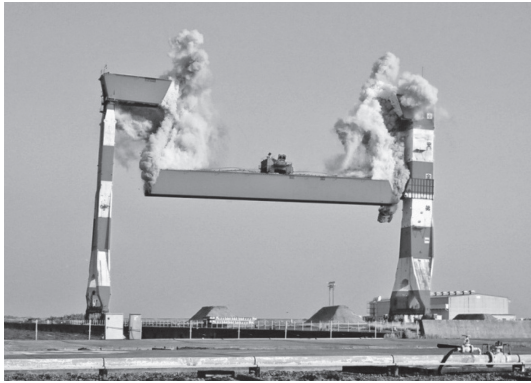
写真—3 大型クレーンの発破解体事例
