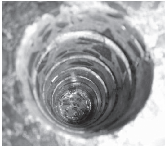
写真一2 溝切削孔後の孔内
