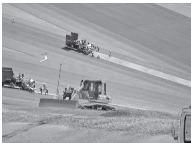
写真一 2 上層路盤の施工状況 (3D-MC システムを搭載したブルドーザ)
