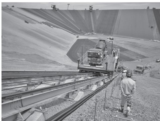
写真一 5 インクラインによる輸送状況
