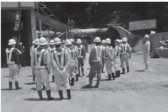
図-5 現場視察状況
