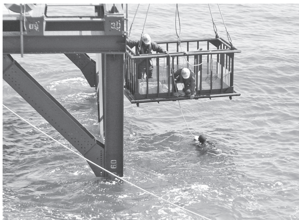
写真—2 潜水夫による調査状況
