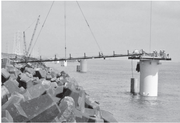
写真一8 中詰めコンクリート打設状況
