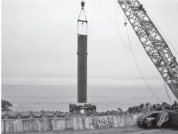
写真-4 モノパイル建て込み状況
