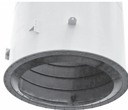
写真-7 ゴム輪取付状況
