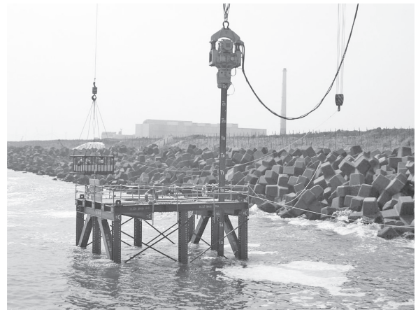
写真-1 障害物探査状況
