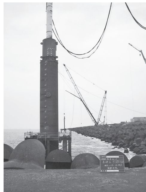
写真-6 S-500ハンマー設置状況
