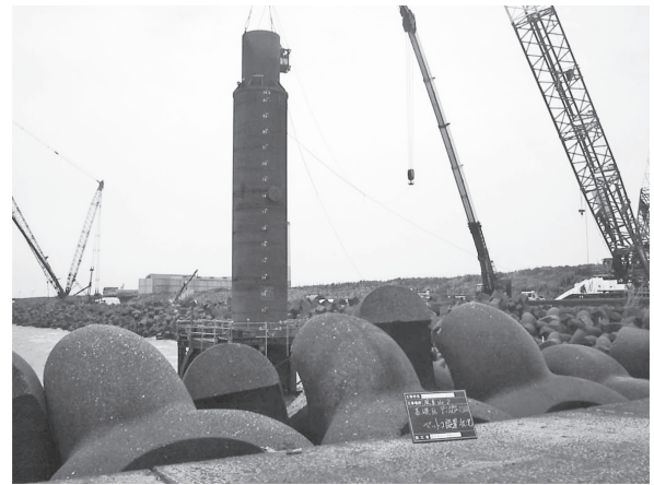
写真-5 ヤットコ設置状況
