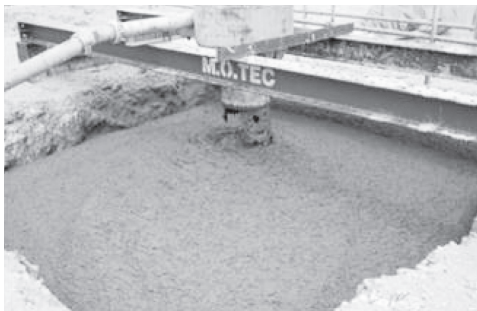
写真一 3 カルシア改質土の打設状況（気中）
