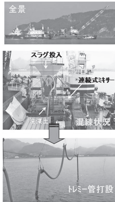
写真一 2 カルシア改質土の施工状況
