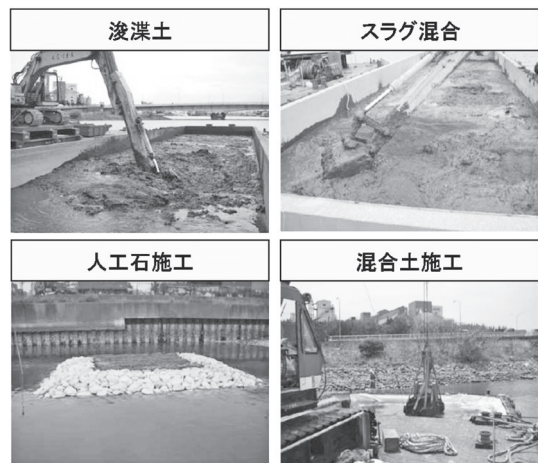
写真一1 東京都城南島での浅場造成実験工事
