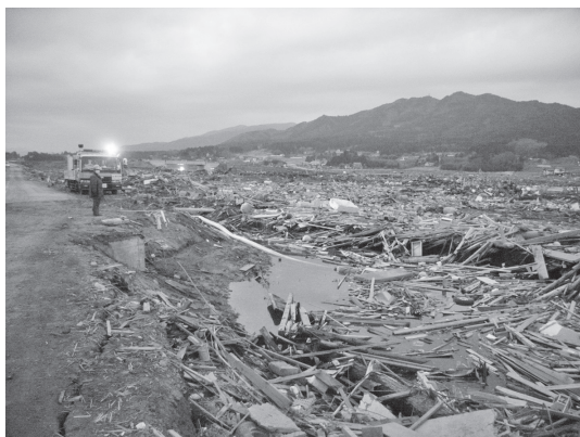
写真一八 夜間に向けての排水作業
