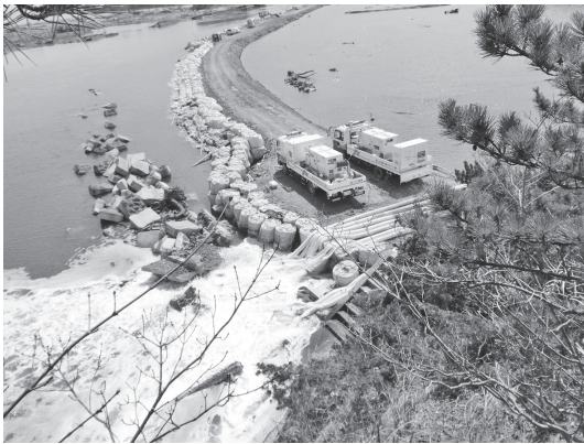
写真—5 排水状況 東松島市潜ヶ浦地区
