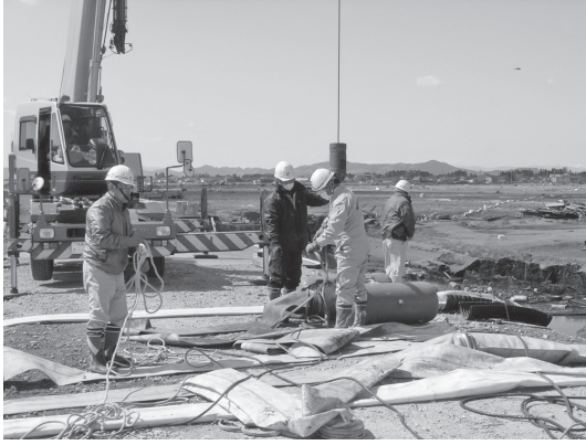
写真—4 派遣したクレーン車による設置作業
