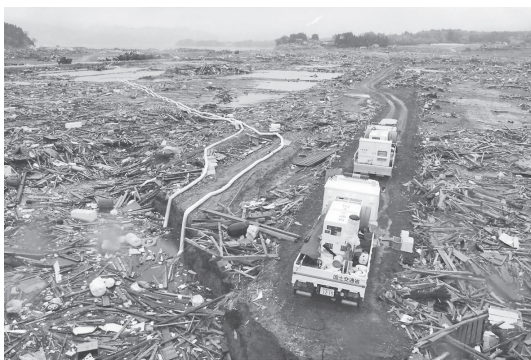
写真一 陸前高田市小友浦地区
