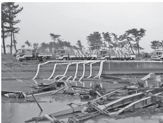
写真一 2 排水作業状況（宮城県仙台市若林区）
