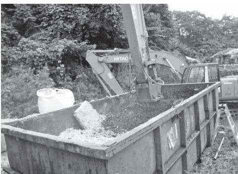
図-5 古紙破砕物の攪拌・混合
