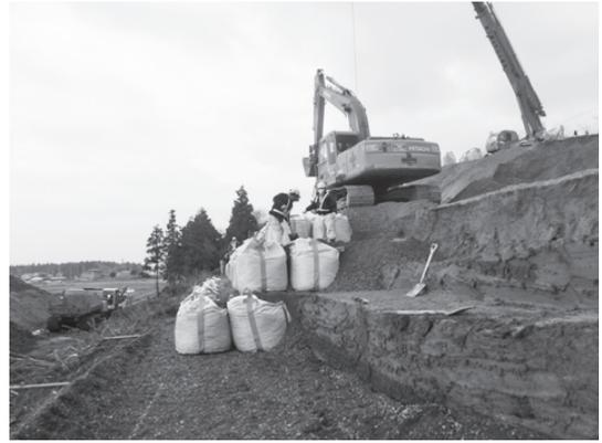
写真一 8 大型土嚢設置
