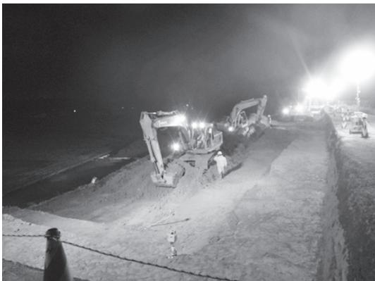
写真一 6 土砂撤去・仮置き（夜間作業）
