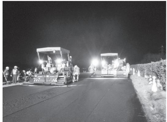
写真一 9 アスファルト舗装工
