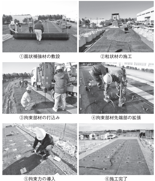
写真—5 本工法の施工状況
