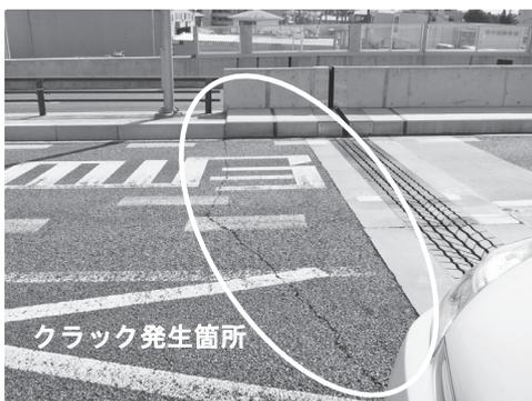
写真-3 ひび割れ発生箇所 (A2 橋台)
