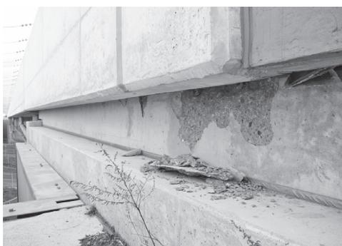
写真-6 鏡川橋底版破損状況
