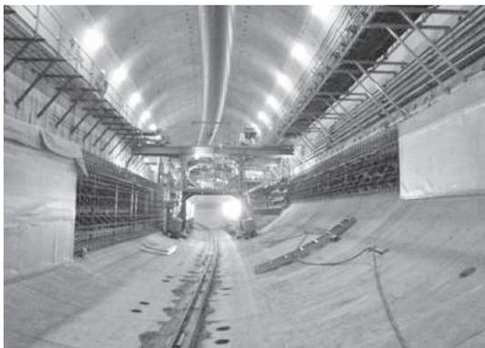
写真-1 床版受部の構築状況（中央環状品川線）
