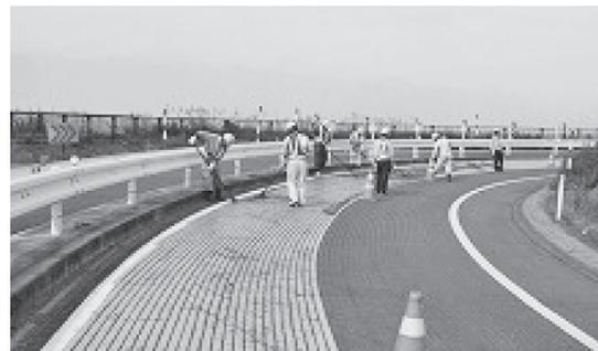
写真一7 凍結抑制材充填状況
