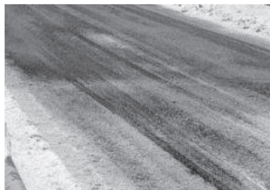
写真一9 物理系凍結抑制舗装の冬期路面
