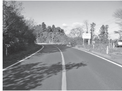
写真—11 路面状況（施工後）
