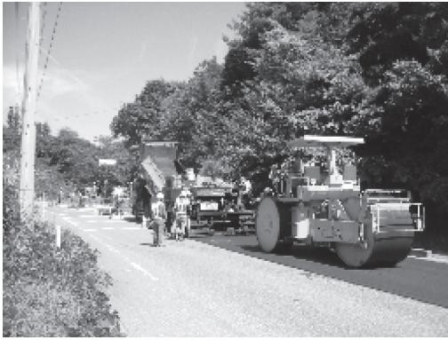
写真—8 敷きならし・転圧状況
