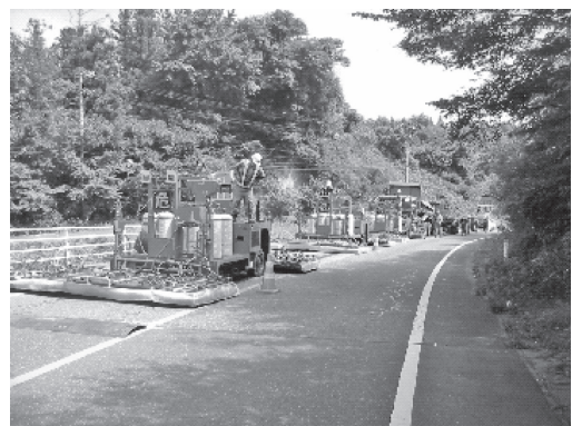
写真-7 小型ヒータ車による路面加熱状況
