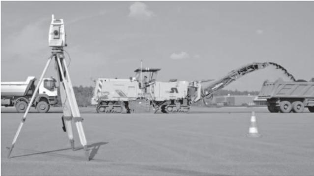
写真一 2 トータルステーションによる路面切削機 3D 制御の状況
