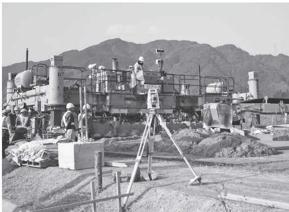
写真-1 稼働中の 3D-MC スリップフォームペーパー
