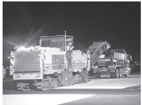
写真一九 3D-MC で切削作業中のクローラ式 RP
