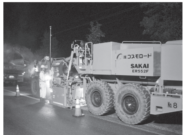
写真一〇 3D-MC で切削作業中のタイヤ式 RP
