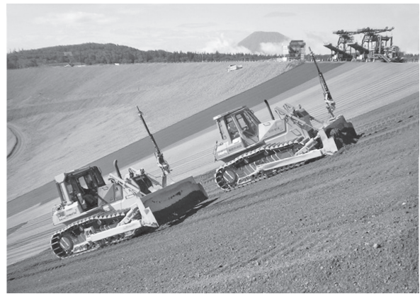
写真一 2 TS 式 3D-MC ブルドーザによるダム法面施工
