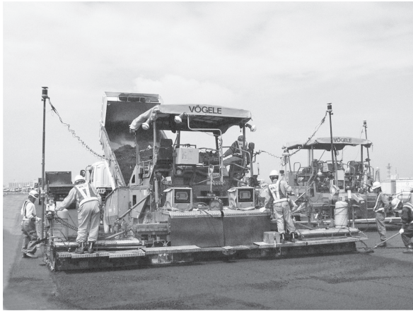
写真一七 両リフト方式（高精度 GNSS）で舗装中の AF
