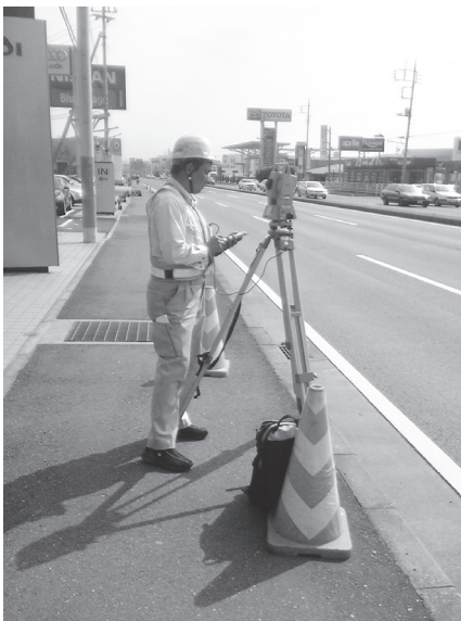
写真-2 計測作業風景
