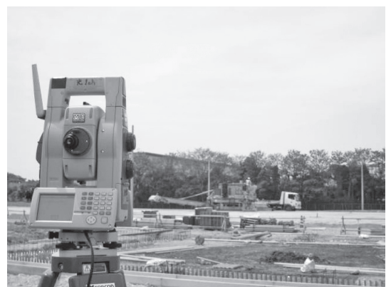
写真一3 情報化施工を適用した施工事例
