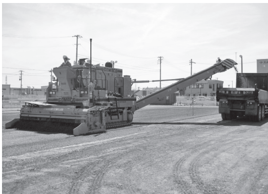
写真-4 施工状況
