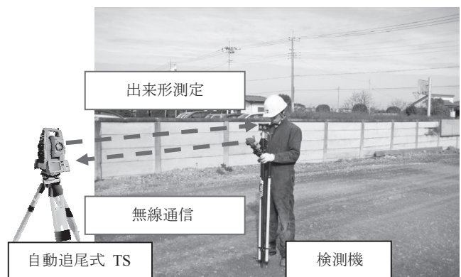
図一五 検測状況
