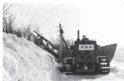
写真—7 履带式除雪ドーザ
