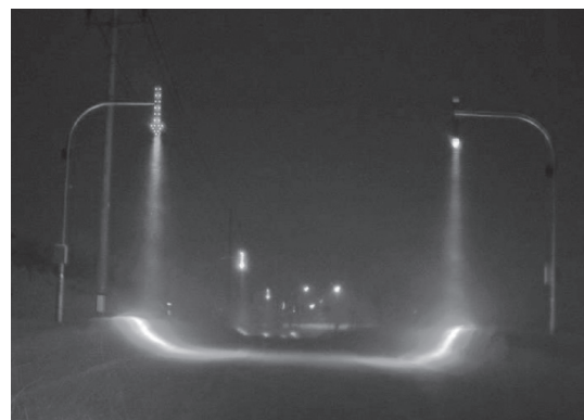
写真一4 現道での点灯状況 (降雪時の柱状の光の形成)
