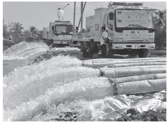
写真一五 排水状況
