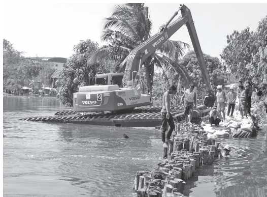
写真一2 現地の作業状況
