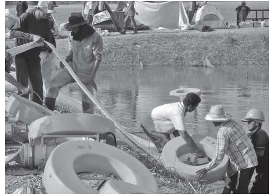
写真—9 ポンプ設置作業
